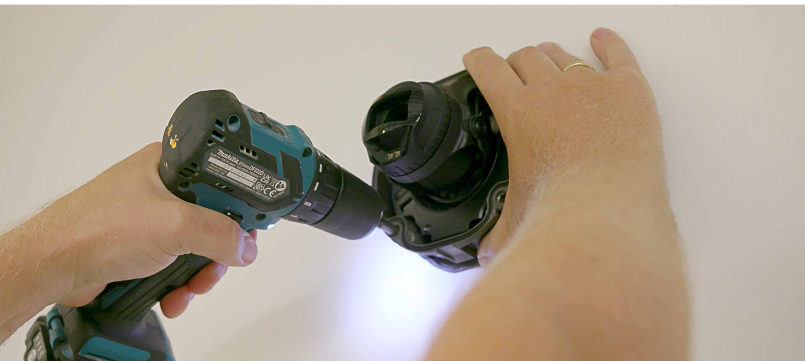
Montering af sikringsløsning i datacentret
